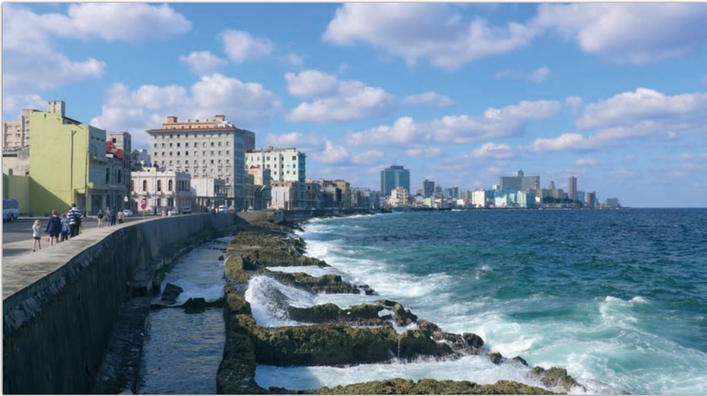
Der Malecon ist ein beliebter abendlicher Aufenthaltsort der Hauptstädter. Die salzige Gischt der Karibik setzt den Häuserfassaden stark zu.
